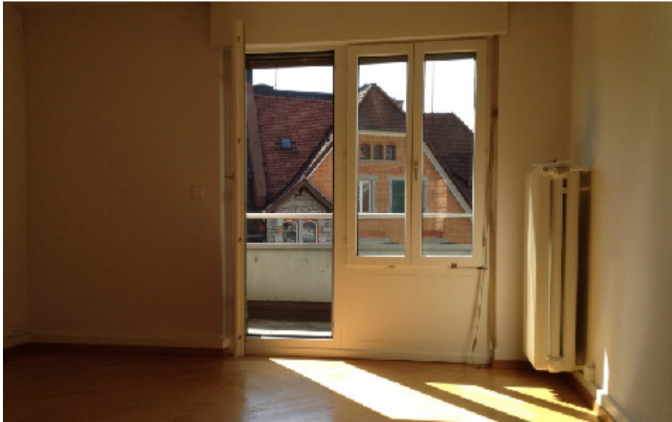
Balkontürschwelle. Birmensdorferstr. 174, 8003 Zürich (1931)
